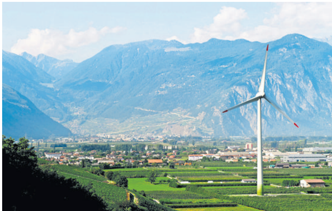
Avec son mât de 100 mètres et ses pales de 50 mètres, l'éolienne Adonis est à ce jour la plus puissante de Suisse. Quatre autres pourraient être érigées dans ce secteur. KEYSTONE
