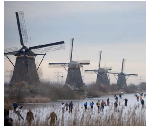
Construits en 1738, ces moulins permettent de drainer les polders. Ils sont inscrits au patrimoine mondial de l'UNESCO. / Kinderdijk, Pays-Bas
